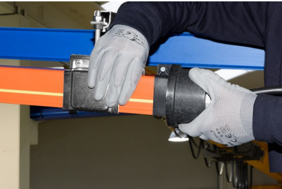
Fermer le bouchon de l'alimentation en bout.
