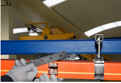
Protéger les connexions avec les couvre joints EMP-4 . Attention de bien enclencher les parties latérales en bas de la gaine PVC
