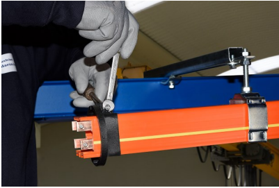
Monter l'alimentation en bout AE-4 et le bouchon TE-4 à l'autre extrémité de la gaine
