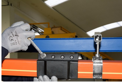
Serrer les vis du couvre joint EMP-4. Les étapes précédentes sont indispensables pour obtenir un bon alignement de la gaine avec la poutre du palan.
