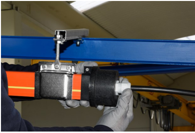
Serrer le câble dans le presse étoupe en laissant un peu de mou pour les éventuelles dilatations.
