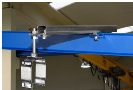
Montar los soportes deslizantes SO-4 y los puntos fijos PF-4 en los brazos de soporte apretando su correspondiente tornillería.
