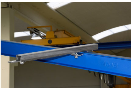
Instalar soportes universales cada 2 o 1,33mts, según el esquema de montaje
